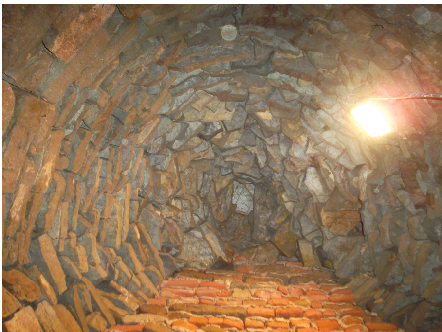
Figura 15: L'interno dell'ambiente sotterraneo a falsa cupola sotto la turris
