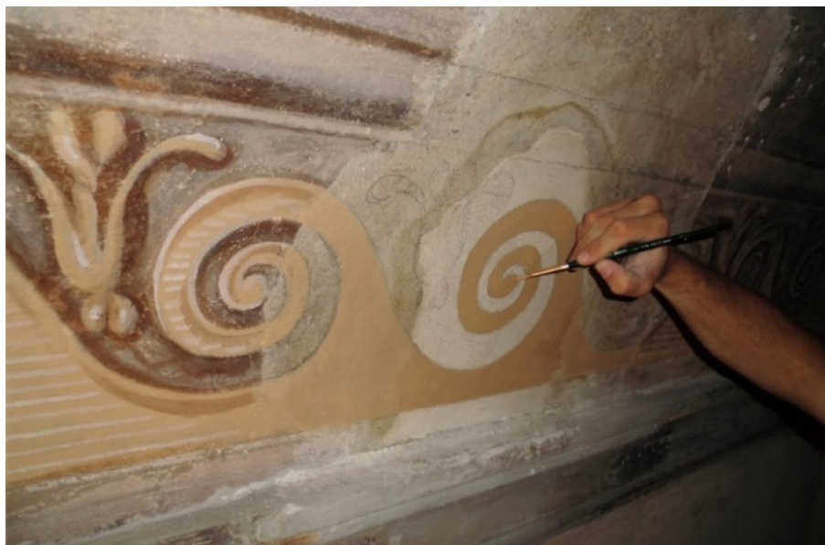
Foto 15 – Ridipintura a secco delle lacune presenti con pigmenti naturali
