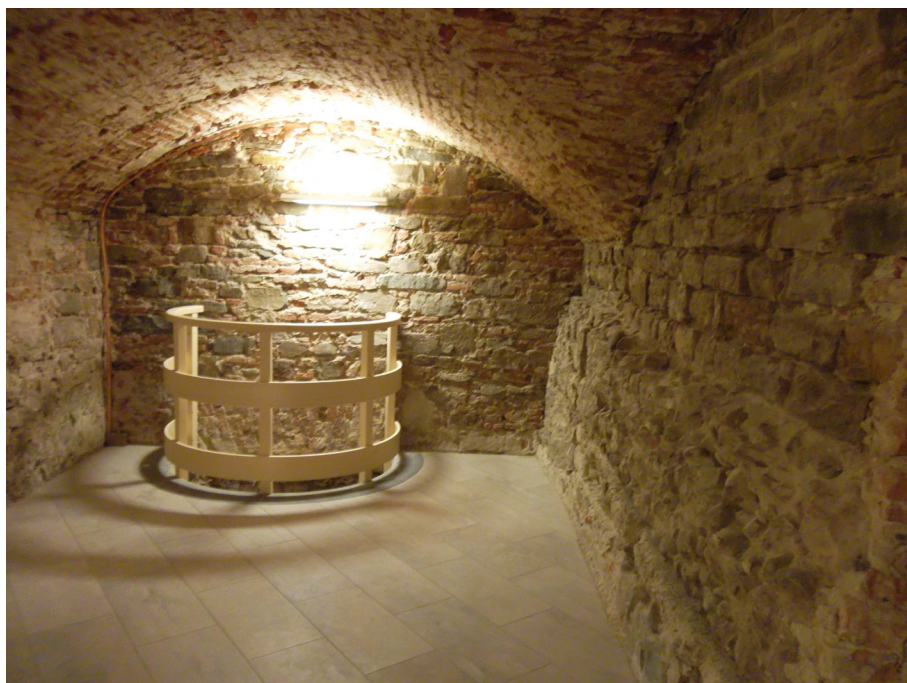
Figura 21: Le fondazioni della turrus duecentesca sulla destra, all'interno del percorso archeologico
