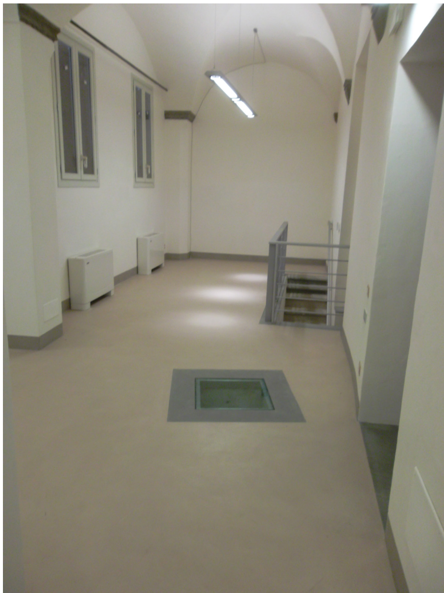
Figura 29: La loggia angolare ed il pozzo dopo i lavori di ripristino
