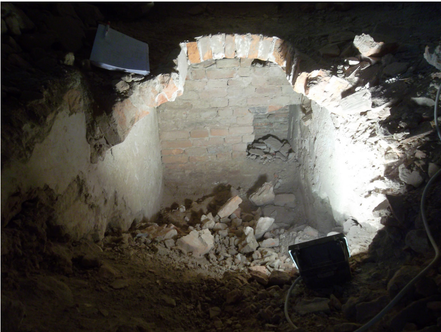
Figura 34: L'originario ingresso dalla loggia allo scantinato retrostante
