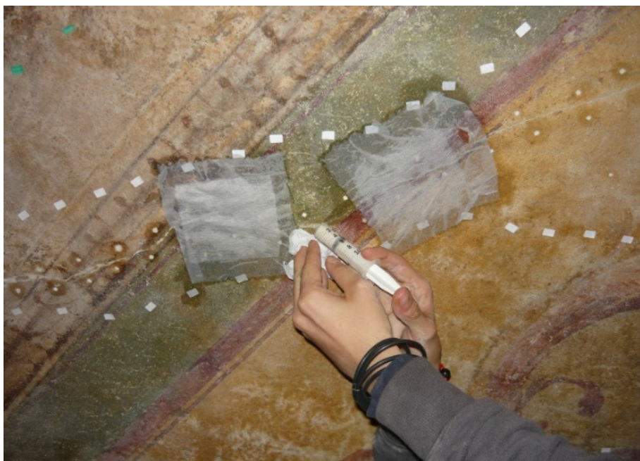
Foto 13 – Consolidamento dell'intonaco con iniezioni di resine acriliche
