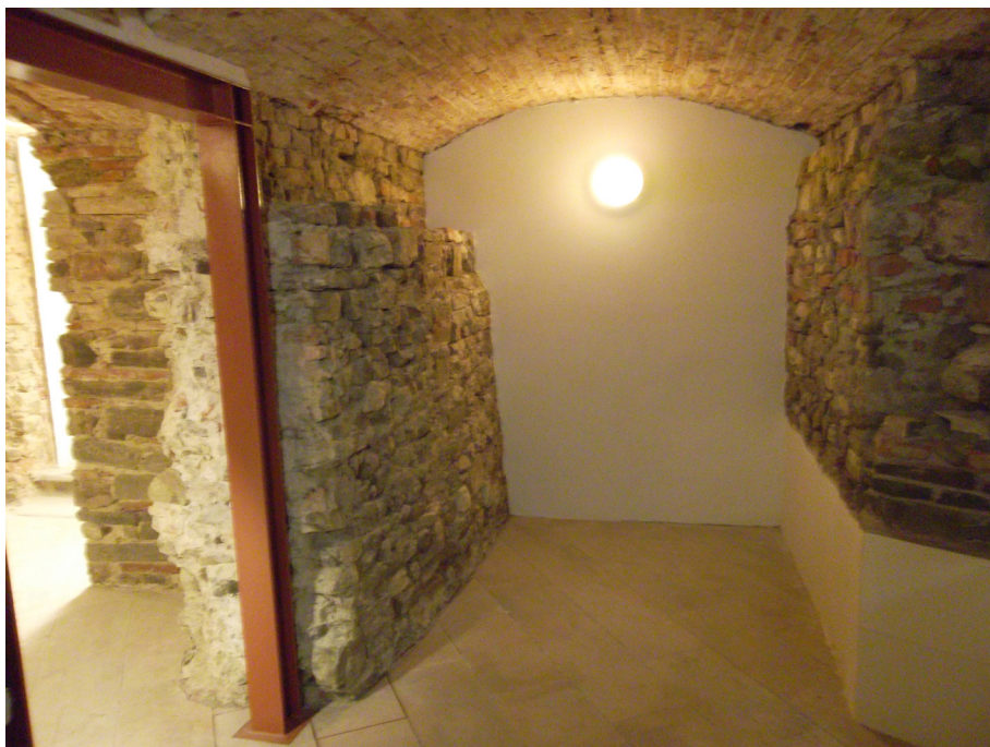
Figura 24: Le fondazioni dei due edifici ad oriente della turris , di cui quello a sinistra venne rasato al suolo per costruire quello a destra
