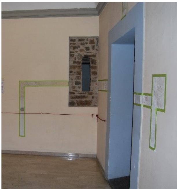
Foto 9 – Saggi propedeutici al restauro pittorico
