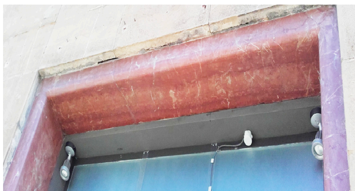
26. Particolare della cornice degli sipiti ed architravi delle aperture dei negozi in marmo rosso Amiata perlaceo
