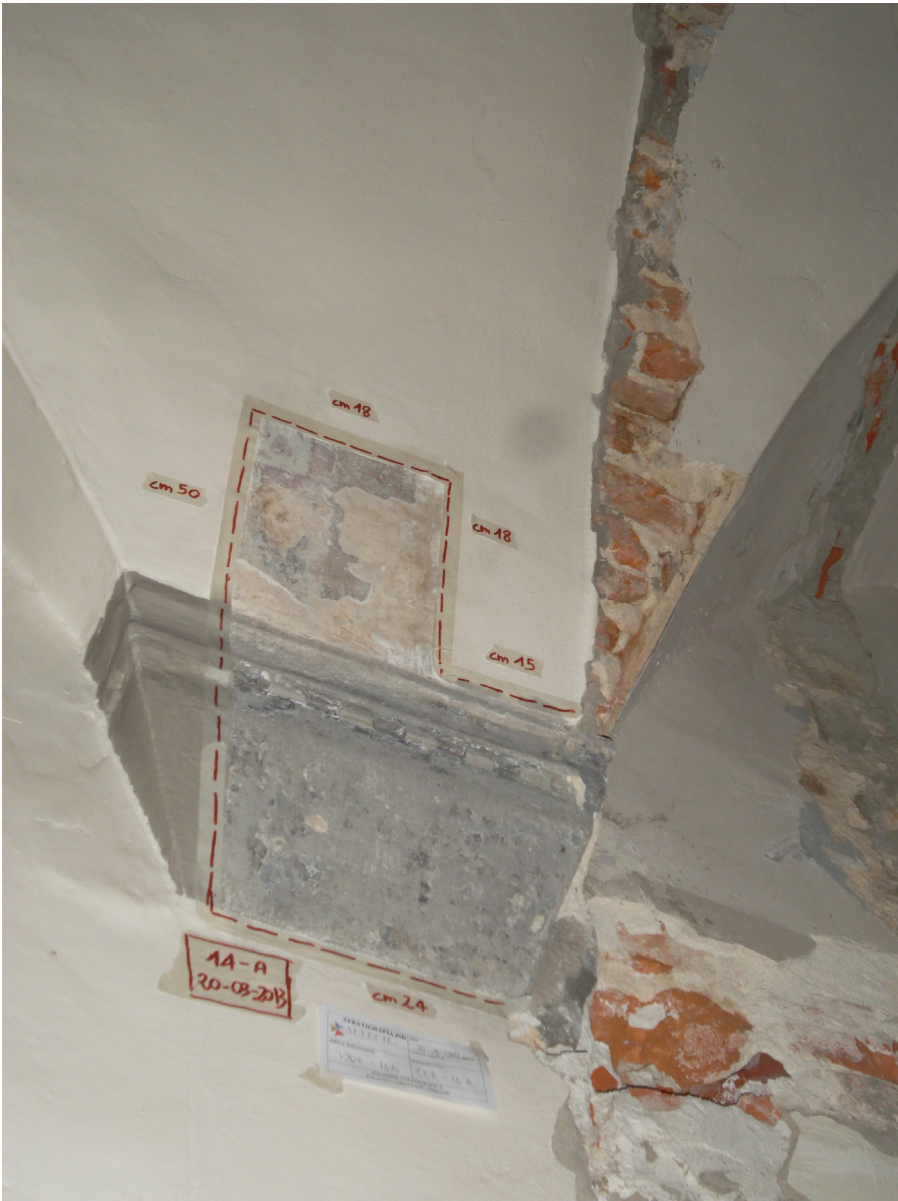
Figura 30: Uno dei peducci della loggia angolare durante i saggi di pulitura
