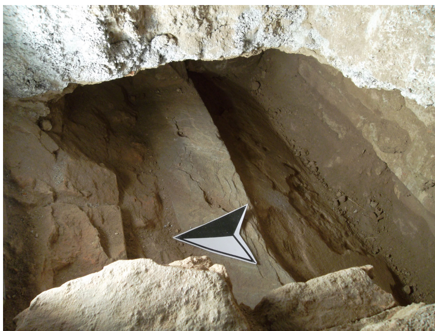
Figura 28: L'abbaino aperto nella facciata settentrionale della turris per dare luce allo scantinato sottostante
