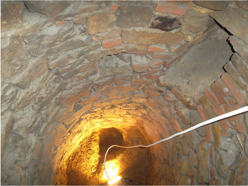
Figura 33: Il pozzo della loggia al momento della scoperta
