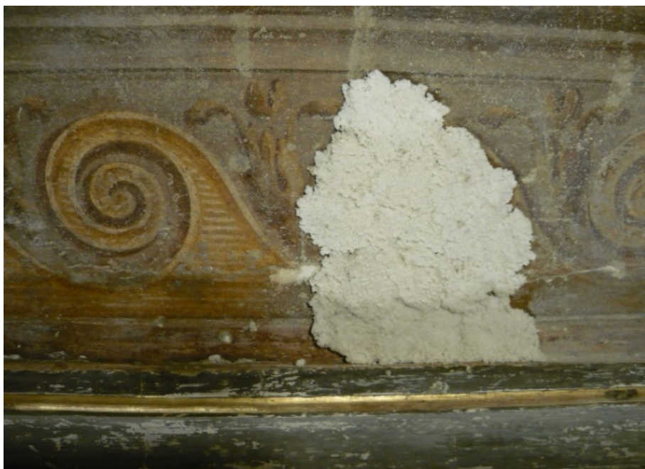
Foto 12 – Impacchi chimici a base di bicarbonato con polpa di cellulosa
