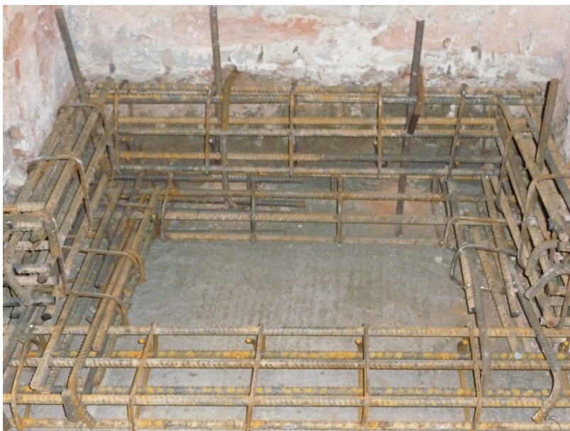
Foto 6 – Rinforzo fondazione mediante cordolatura in c.a.
