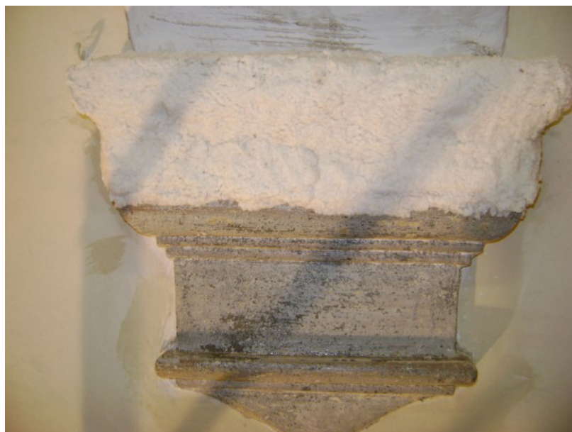
Foto 36 – Impacchi con polpa di cellulosa
