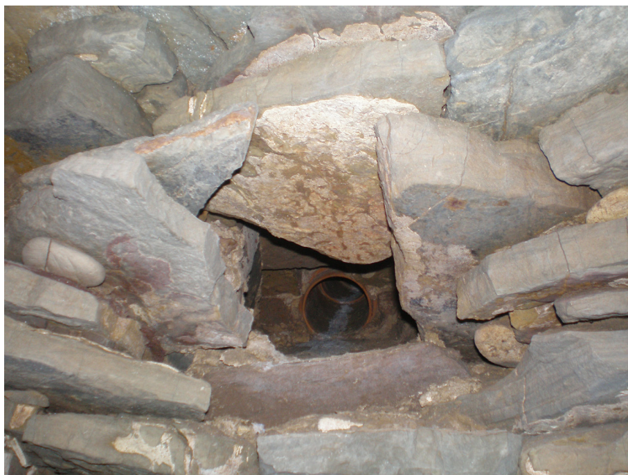
Figura 23: La cassetta di raccordo tra il sistema di raccolta delle acque piovane e l'interno dell'ambiente sotterraneo a falsa cupola sotto la turris
