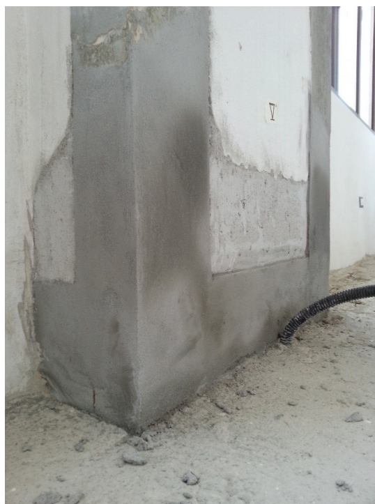
Foto 37 – Ricostruzione di lacune nei pilastri
