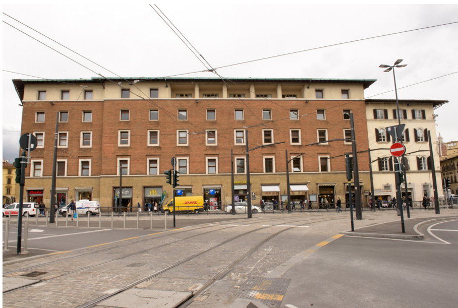
20. Veduta attuale della facciata su piazza della Stazione
