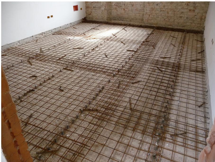
Foto 5 – Rinforzo solai esistenti con connettori metallici
