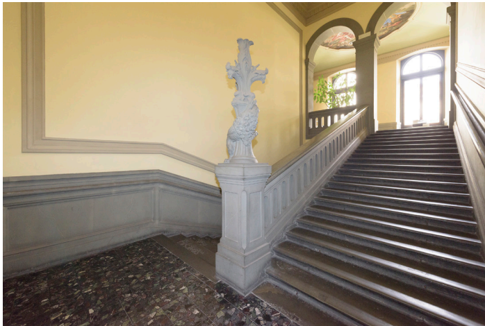
18a-b – Lo scalone monumentale che conduce con due comode rampe dal piano terra al piano primo
